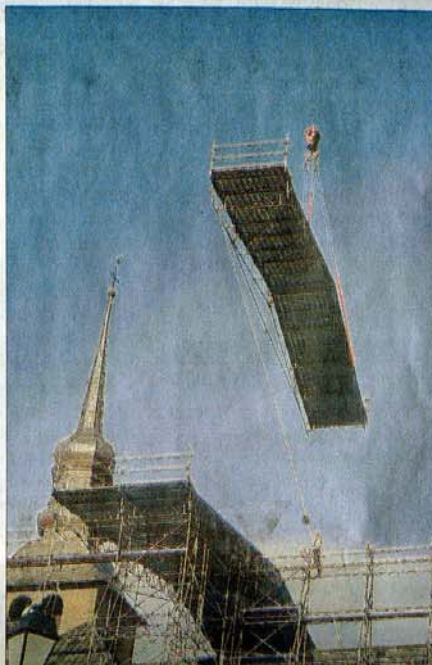
L'immense chantier de rénovation et de réhabilitation de l'église Notre-Dame de l'Assomption a débuté par la mise en place d'un "parapluie", comprenez un deuxième toit temporaire, qui va permettre aux charpentiers de travailler à l'abri des intempéries et ainsi protéger le trésor pictural à l'intérieur.
