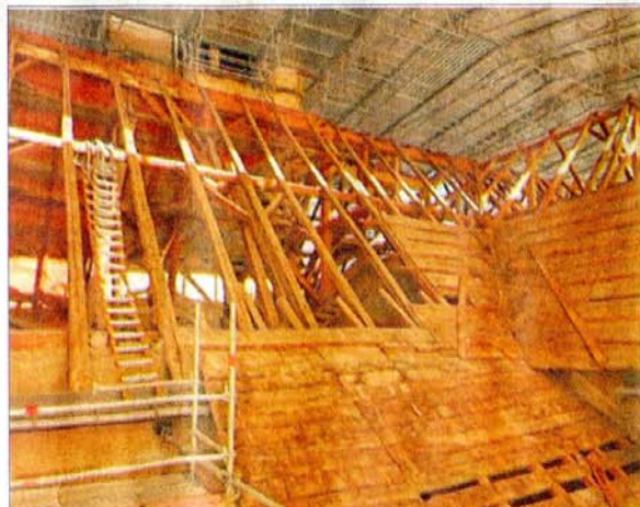
Le bois utilisé pour la charpente provient de la forêt communale. Ce sont près de 300 m 3 qui ont été coupés pour la rénovation de la charpente. La restauration des façades interviendra plus tard, une fois le gros œuvre achevé.
