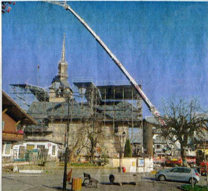
L'immense chantier de rénovation et de réhabilitation de l'église Notre-Dame de l'Assomption a débuté par la mise en place d'un "parapluie", comprenez un deuxième toit temporaire, qui va permettre aux charpentiers de travailler à l'abri des intempéries et ainsi protéger le trésor pictural à l'intérieur.
